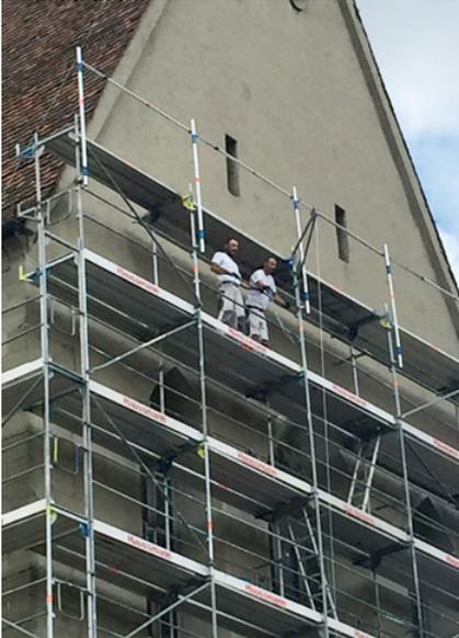
Auf der sicheren Seite, beim Aufbau mit Montage-Schutz-Geländer (MSG) - oder mit entsprechender PSA (Persönlicher Schutz-Ausrüstung), wenn es mal wieder besonders wird.
